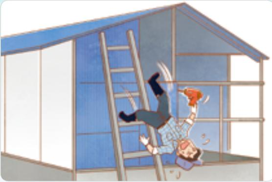
축사 보수를 위해 조립식 판넬 설치 작업을 위해 사다리 위에서 전기드릴을 이용하여 스크류 볼트 체결작업을 진행하던 중 사다리 유동으로 몸의 중심을 잃고 약3.8m 아래 지상으로 추락하여 사망한 재해임
